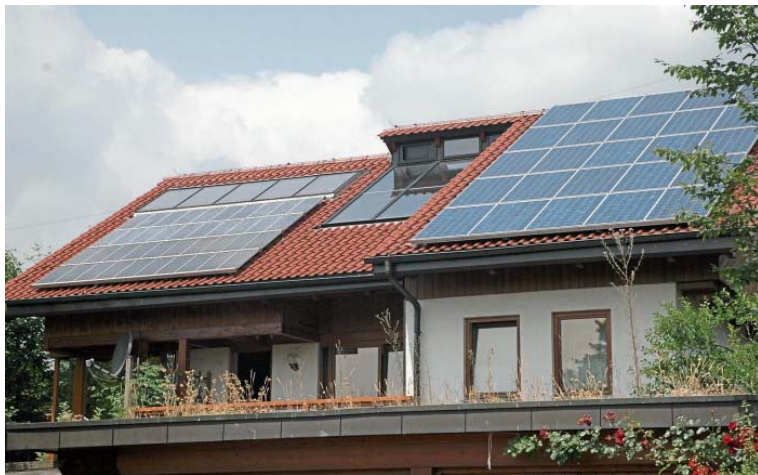
Diese Anlage baute Otmar Braune 2004 auf einem Süd-Ost-Dach, vergangenes Jahr hat er aber auch noch ein Nord-West-Dach bestückt. Foto: Braune
